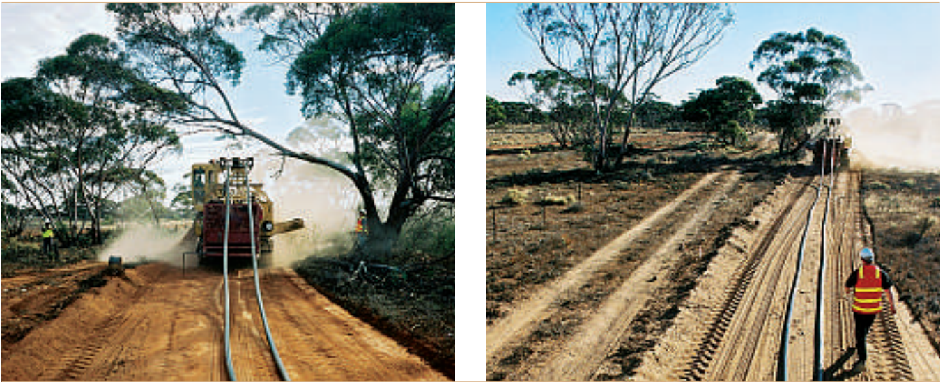
5 Bau der Murraylink HVDC Light®-Verbindung (Australien)
